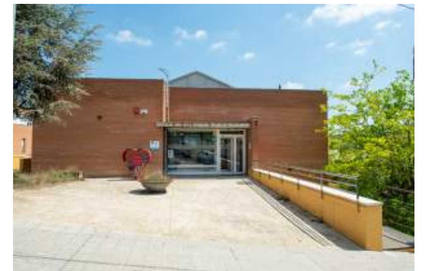
Consultori local La Torreta
