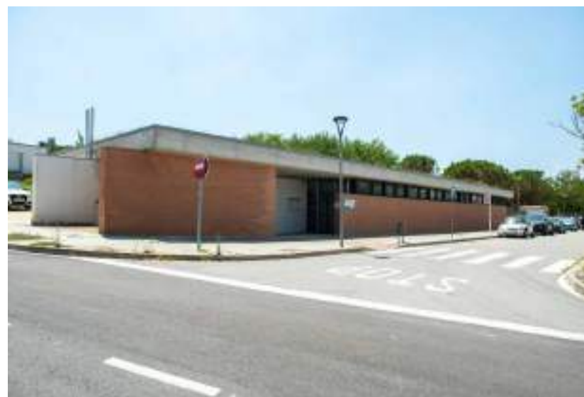
Consultori local Santa Agnès de Malanyanes
